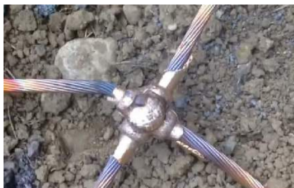
Exemples de soudures avec les moules CC4 et CR2
