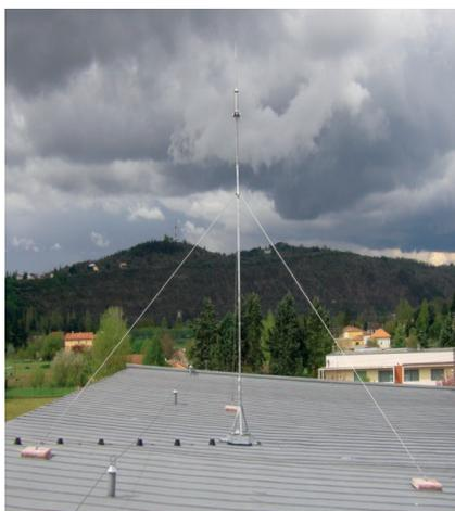
Le kit de haubanage permet de maintenir l'intégralité des paratonnerres et mâts rallonges de la gamme FRANKLIN France ainsi que les pylônes en poutre de treillis métalliques selon le type d'installation souhaité et la région de vent. Il est composé d'une couronne en fibre de verre Ø 5,6 mm de 25 m, 3 tendeurs à lanterne, de 6 pinces d'ancrage, d'un collier de haubanage 3 directions, de 3 manilles inox Ø6mm et d'un lot de 3 chevilles à expansion Ø10mm.
