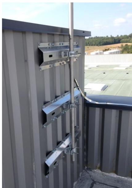
Livrée avec 16 vis autoperceuses 6,3x60 mm avec rondelle d'étanchéité + joints EPDM préinstallés
