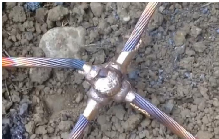
Exemples de soudures / Examples of weldings / Ejemplos de soldaduras
